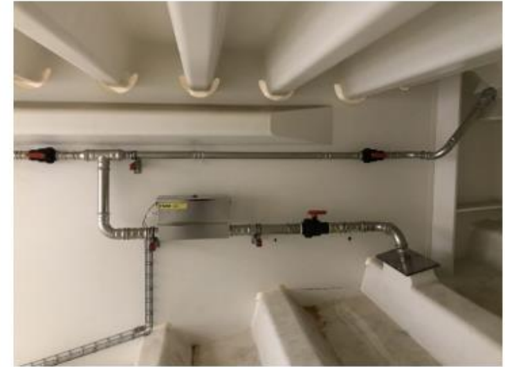
Miglioramento impianto deumidificazione interna
