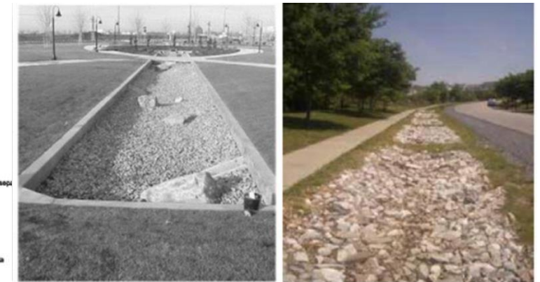
Tipologico di trincea d'infiltrazione
