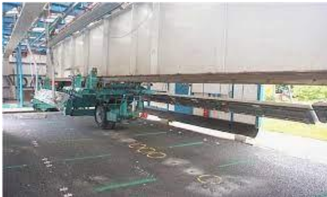
Test sulla pavimentazione ultrasottile
